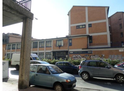
Figura 1.1 - Vista della facciata esposta a sud
