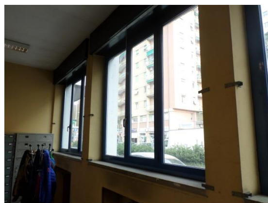
Figura 4.4 - Particolare dei serramenti
